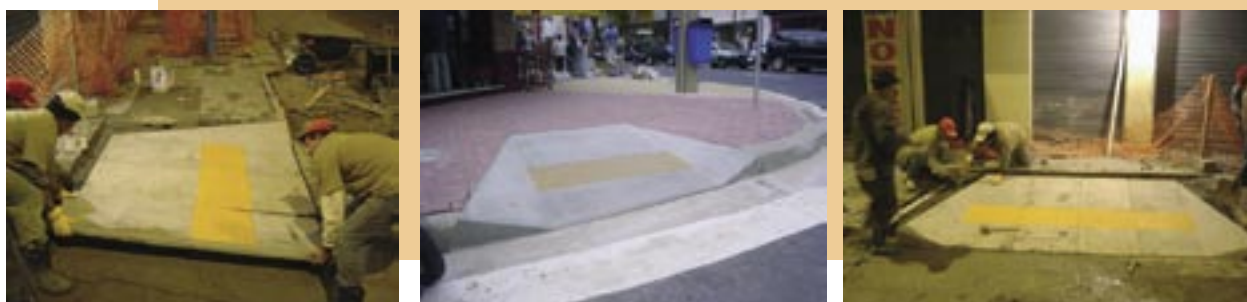
Promoção de acessibilidade: construção de calçada acessível
